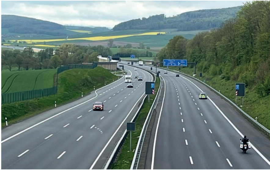
Blick auf die fertige Autobahn
