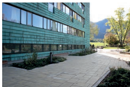
Bild 03: Außenbereich Retentionsraum westlicher Klinikbereich, entlang der Fassade als Streifen erkennbar die Aquawand
