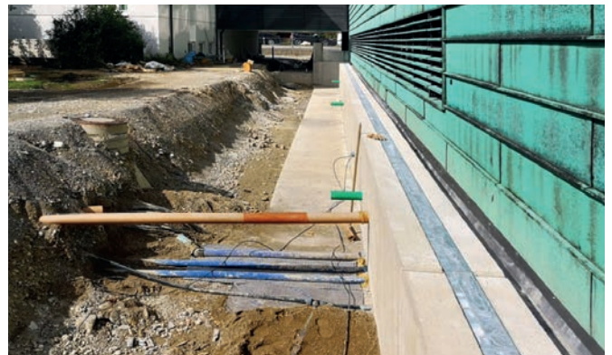
Bild 05: Aquawandkörper nach dem Ausschalen des Betonkörpers, Entwässerungspunkte der Stahlkörpers (grün), Querung der Medientrasse.
