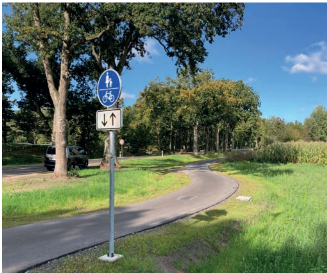
Calberlaher Damm mit neuem Radweg
