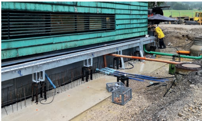
Bild 04: Montage der Stahlkonstruktion der Aquawand auf dem Fundamentkörper im westlichen Bereich des Klinikums.
