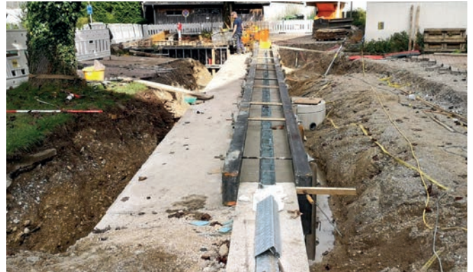
Bild 02: Fundamentkörper Aquawand (links) und Abschalung des oberflächensichtbaren Betonkörpers der Aquawand
