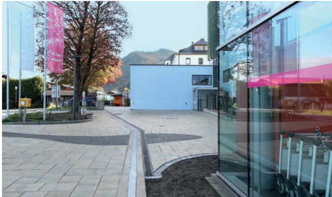
Bild 01: Hauptzugang Klinikum nach Abschluss der Maßnahme, im Zentrum die abknickende Abdeckung der Aquawand.
