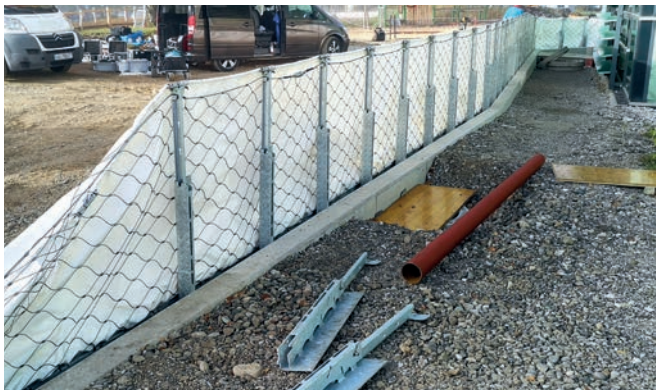
Bild 06: Testaufbau der Aquawand. Die mobilen Pfosten sind fest mit der Abdeckung verbunden und als Steckbauteile schnell montiert. Die Pläne mit Metallnetz verbirgt sich unter der Abdeckung im Stahlkasten und wird im Einsatzfall herausgezogen und an den Stützen befestigt.
