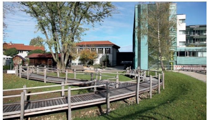
Bild 07: Teilbereich des neuen Spielplatzes. Deutlich zu sehen sind die tiefen Ausmuldungen der Retentionsräume im Südwesten des Geländes. Unter dem Weg rechts befindet sich ein großer Rigolenkörper für die gepufferte Ableitung der Binnenwasser.
