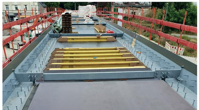
gegebenen Reihenfolge erforderlich. Dies bedingte eine äußerst genaue Bewehrungsführung und die genaue Ausbildung der Anschlussbewehrung in den Arbeitsfugen der einzelnen Bauabschnitte. Die Einbauteile für die Rückverankerungen und die Pylonsockel wurden im Stabspannverfahren mit Verbund der Fa. Dywidag eingebaut und vorgespannt.
