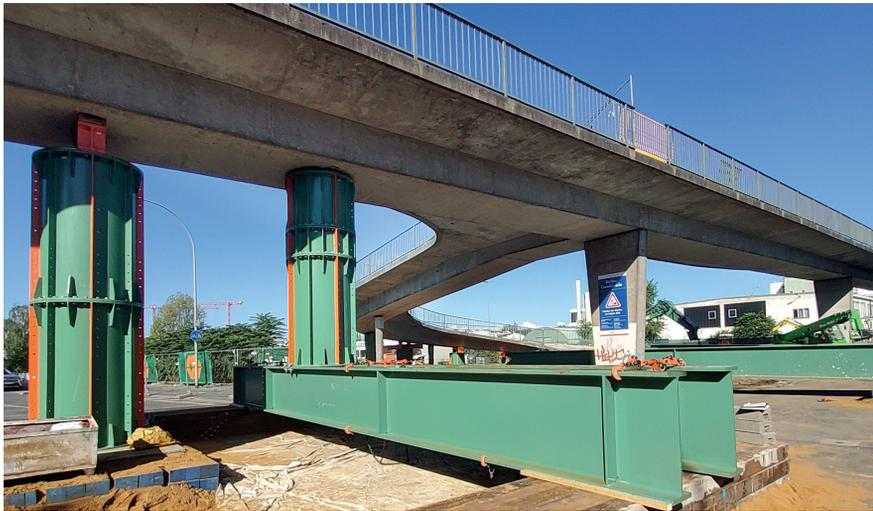
Hilfsstütze: Als Hilfskonstruktion bis zu einer Höhe von 4,50 m wurden Tonnenstützen eingesetzt. Um den Kanal vor zu hohen Belastungen zu schützen, wurden Joche zur Lastverteilung bzw. -überbrückung eingesetzt.
