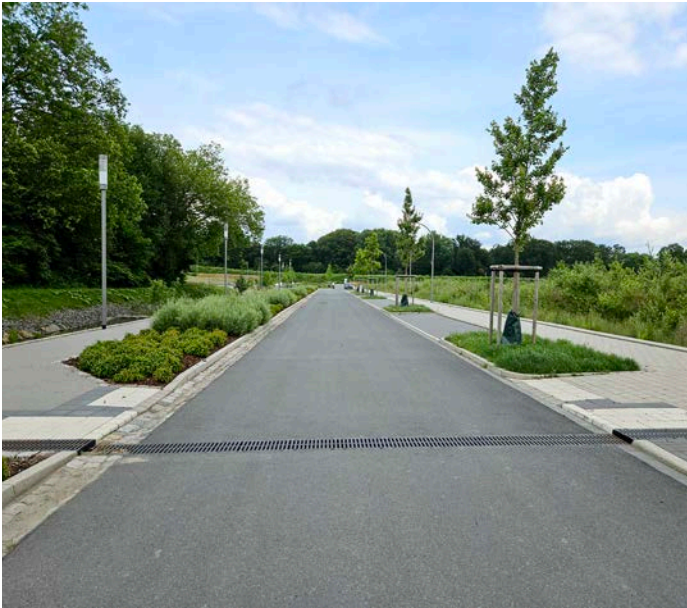
Wasserführung quer zur Fahrbahn über Kastenrinnen
