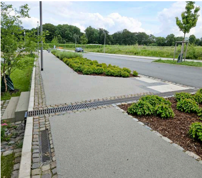
Regenwasserableitung über Kastenrinne in die Gracht
