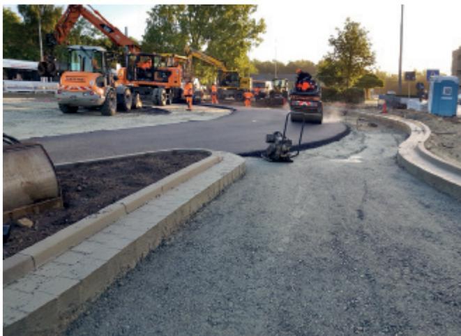
Bushaltestelle Roland-Center - Einbau Asphalttragschicht
