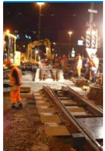
In den besonders belasteten Verkehrsknotenpunkten wurden die Arbeiten auch nachts und am Wochenende durchgeführt.
