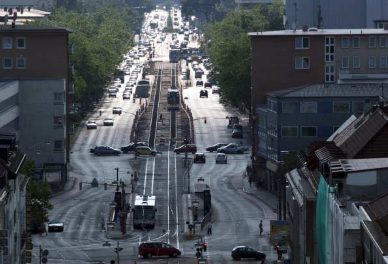
Blick vom „Langen Ludwig“ am Luisenplatz in Richtung Westen auf die Baustelle in der Rheinstraße (Bildnachweis HEAG).
