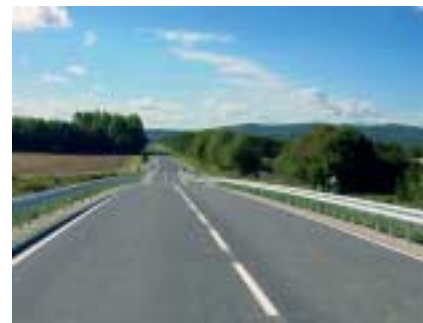
Die Nord-Süd-Straße am Hillenholzknoten mit Blick in Richtung Harz.
