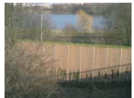
Durch die vorgezogenen Pflanzen werden die Lärmschutzwände bereits in wenigen Jahren vollständig begrünt sein.
