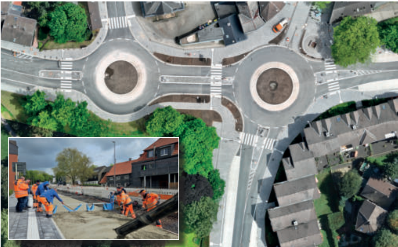
Zustand nach Herstellung sowie Betoneinbau (unten links)
