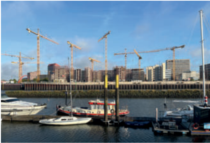
Derzeitige Bautätigkeiten im Bereich Stephanitorquartier
