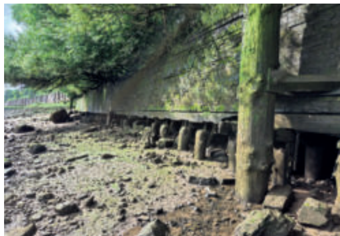
Bestandskonstruktion mit Holzpfahlgründung aus dem Jahr 1860
