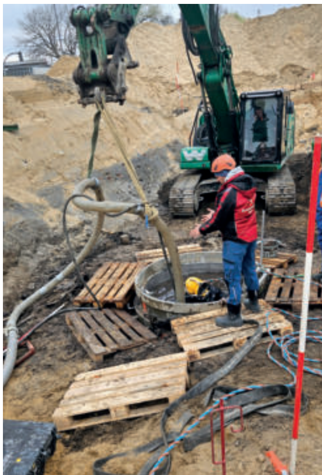
Der Taucher beim Freispülen und Abtasten der Anomalie
