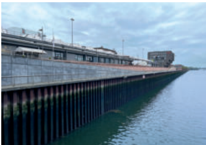
Neu hergestellte Südkaje mit Promenade im Bereich Schuppen 2
