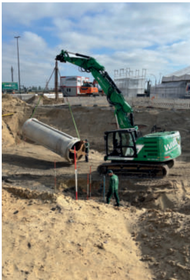
Einsatz des Bergungsrohrs
