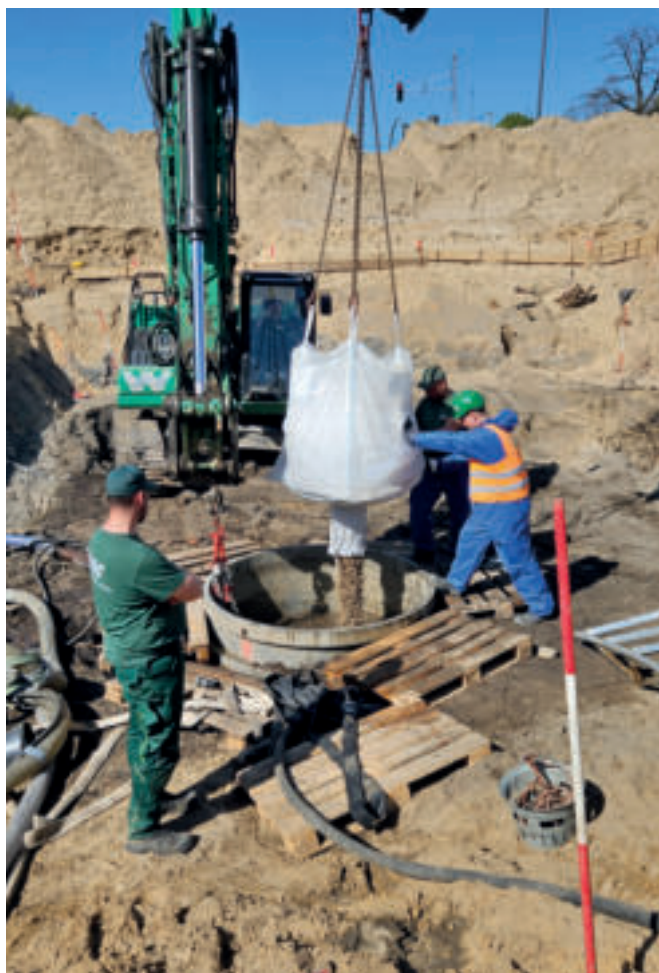
Wiederverfüllung der Baugrube mit Blähton
